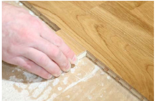
Neue Diele: untere Nutwangen entfernen
