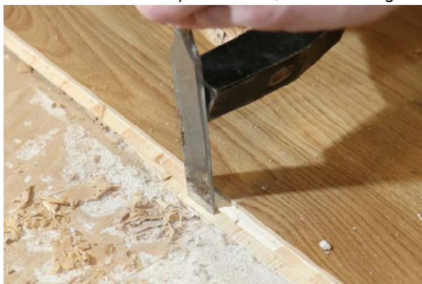
Kleber vom Estrich schälen (Fein Multimaster)
