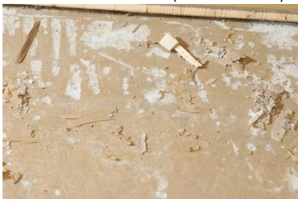
Kleber vom Estrich schälen (Fein Multimaster)
