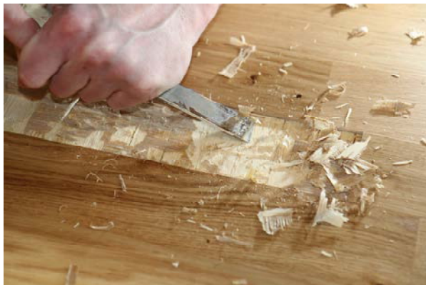
Leimschicht + 1 mm der Mittellage entfernen
